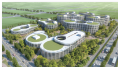
上海金橋臨港プロジェクト
