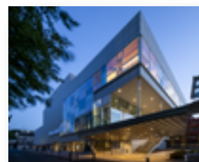
港南区公会堂・土木事務所
